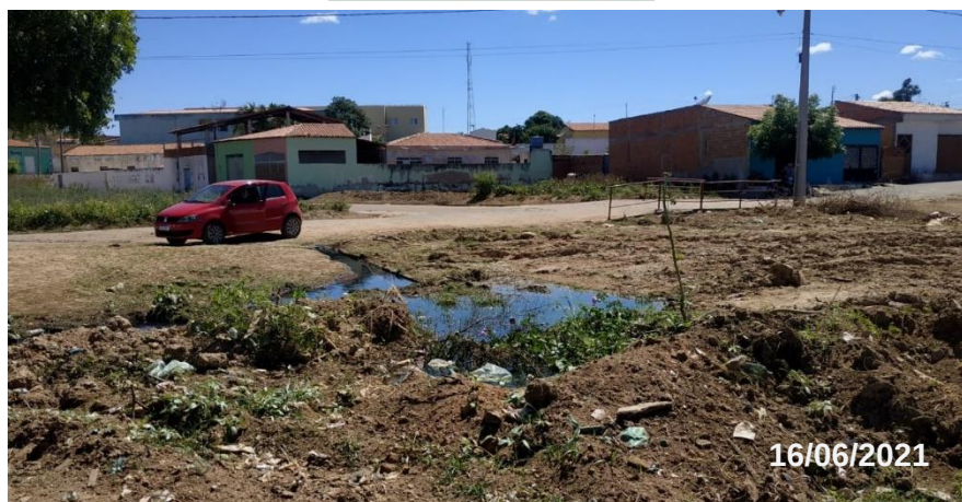
Foto 03 – Esgoto a acumulado ao lado de ruas. (Área 01) – 16/06/2021
